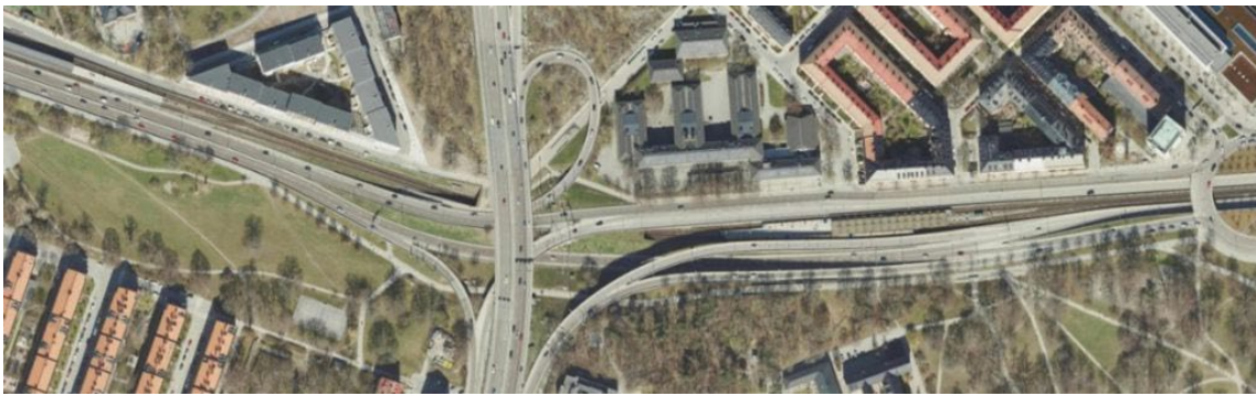
Flygfoto över trafiklederna tvärs västra Kungsholmen
