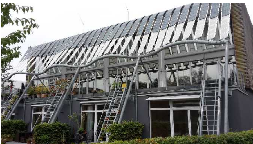
Figur 14. Solpaneler i textil som följer ljuset under dagen.
