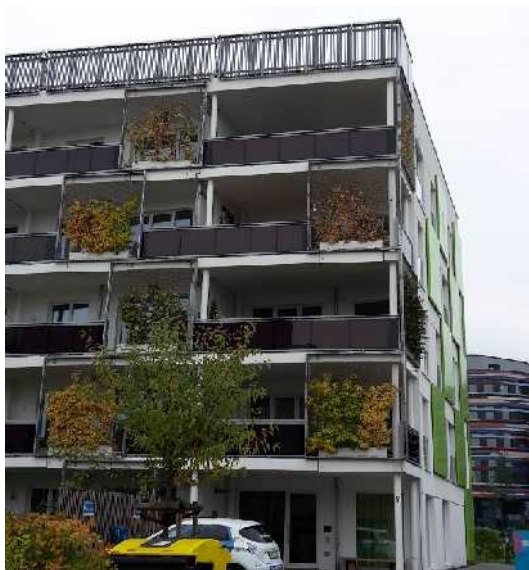
Figur 13. Byggnad där solceller placerats på balkongerna.
