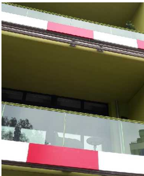
Figur 12. Husets fasad producerar biomassa i de paneler som normalt sitter mellan de röd-vita listerna.
