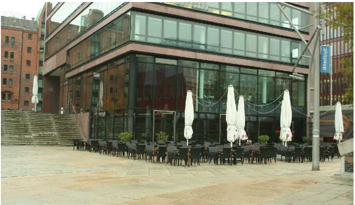
Figur 3. Restaurang/bar med fönster som klarar att nedre våningen står under vatten.
