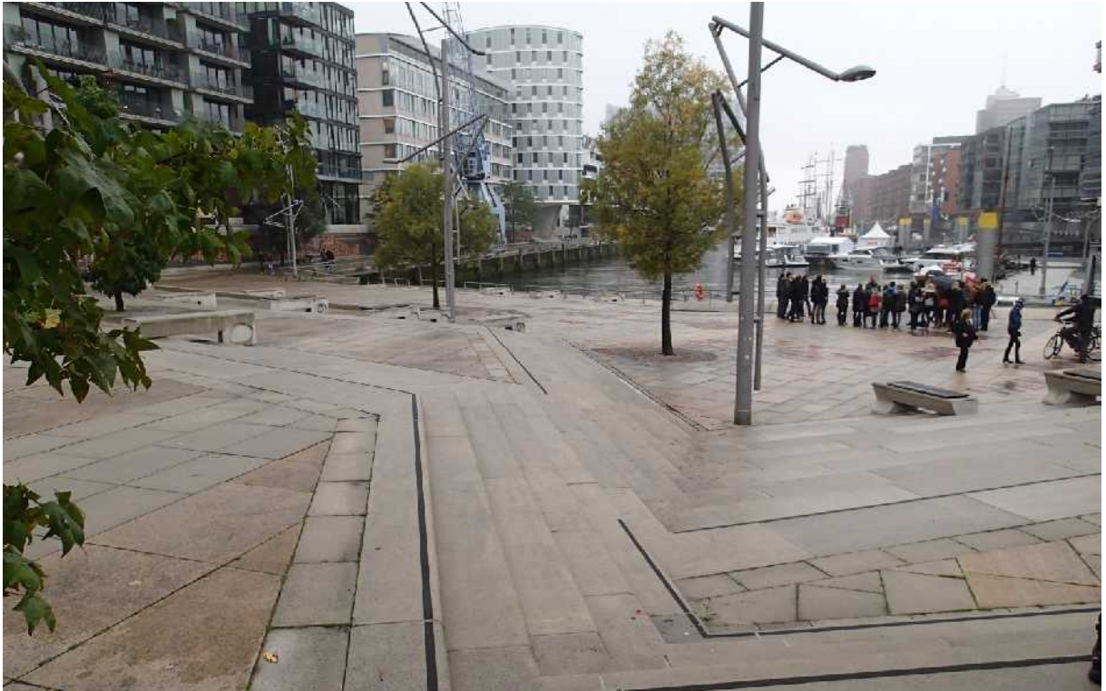
Figur 2. Allmän yta, anpassad för att kunna stå under vatten vid översvämning. Bakom ryggen ligger restaurangen i nedre bilden.
